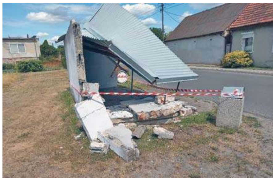
Zniszczona wiat przystankowa w Starej Wsi (fot. FB - Gmina Nowa Sól)
