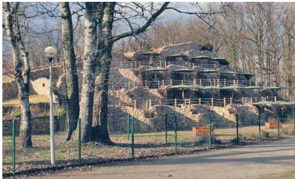
Trwają prace, by to miejsce zaczęło żyć
