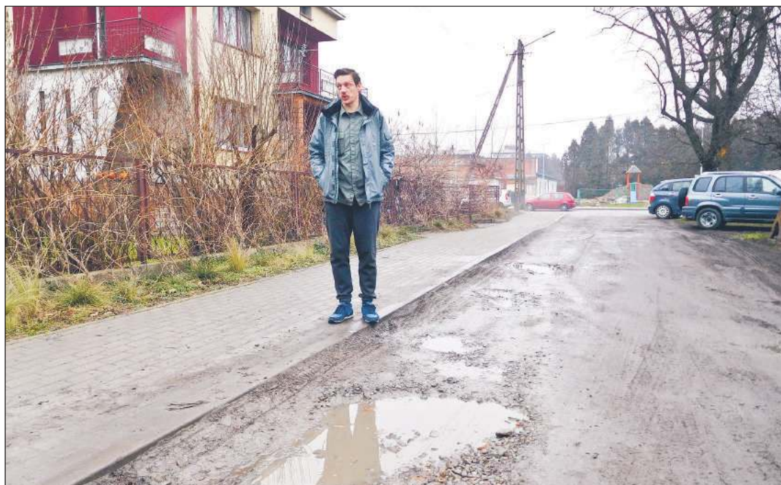
Damian Sasiadek denerwuje się, że kierowcy rozjeżdżają nawierzchnię, a miasta nie stać na jej utwardzenie.
