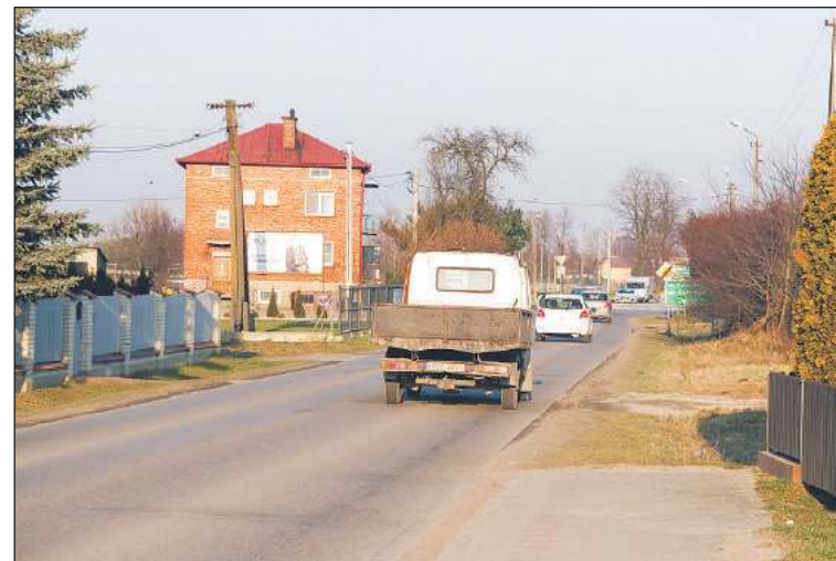
Brakujący chodnik powstanie, ale dopiero po przebudowie gazociągu.
