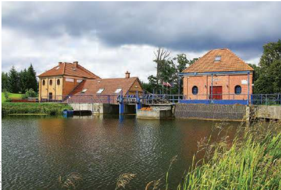
Tama i elektrownia wodna na Węgorapie w Ołowniku
