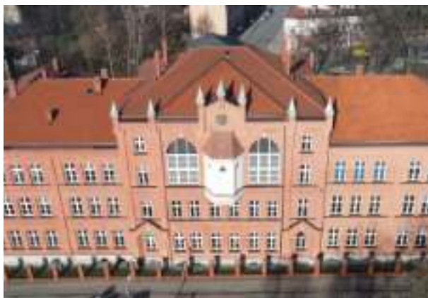
► Termomodernizacja kolejnych szkół Fot. Kamil Rapior
