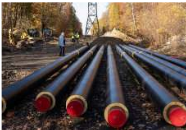
► Budowa sieci ciepłowniczej w Rokitnicy i Helence Fot. UM Zabrze
