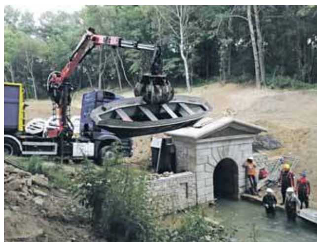
Za moment stara łódka trafi do kontenera. W Sztolni Czarnego Pstrąga wymieniono na nowe 10 łodzi
