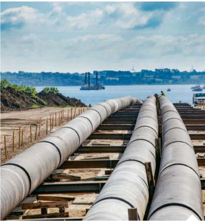
Dzięki dobrej współpracy gazociąg Baltic Pipe będzie oddany na czas, czyli do 1 października tego roku | fot. mat. pras./d
