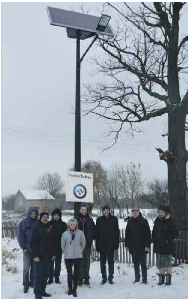
Dzięki zaangażowaniu stowarzyszenia w Cichostowie stanęło pięć takich lamp. Teraz przy drodze powiatowej będzie jaśniej i bezpieczniej
