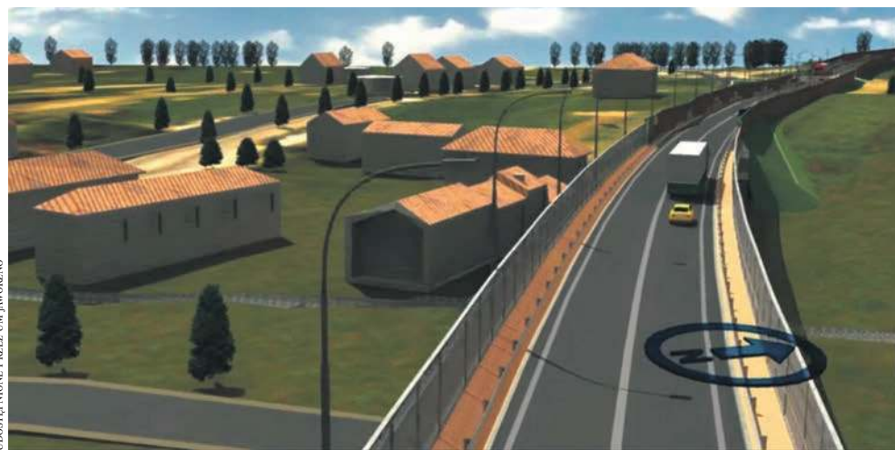
Estakada na mieć długość 166 metrów. Będzie pięcioprzęsłowa
