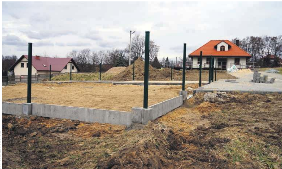
Rozpoczęła się budowa placu zabaw w sąsiedztwie domu wiejskiego w Porębie Żegoty
