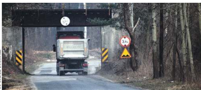
W kwietniu ma być zdemontowany stary wiadukt na Powstańców Styczniowych w Chrzanowie
