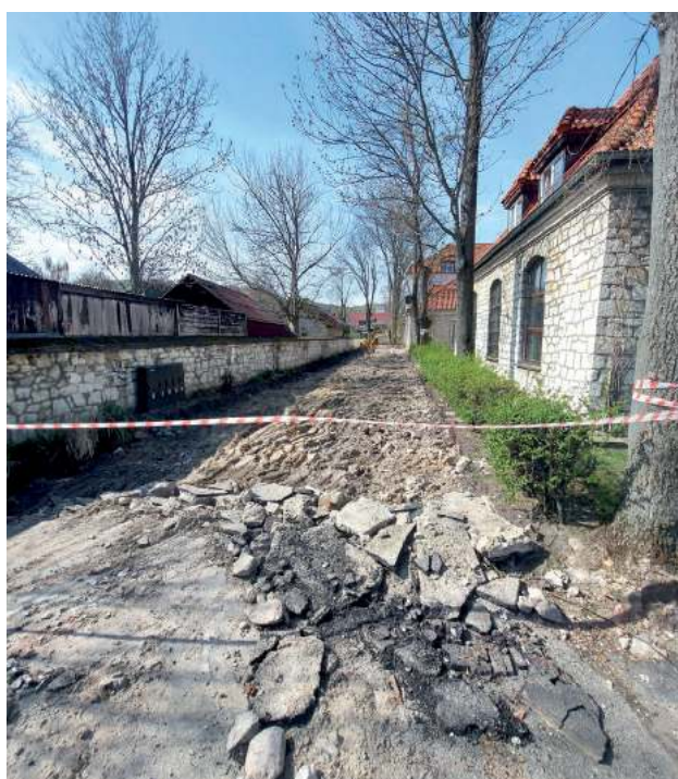
Na razie trwają prace związane z zagospodarowaniem terenu wokół Zespołu Szkół im. Jana Koszczyc Witkiewicza. Potem remont przeniesie się na szkolny budynek
