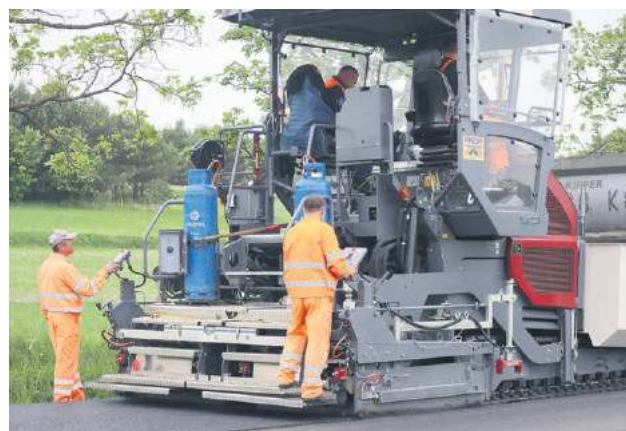
Wyremontowanych zostanie 14 km dróg.
