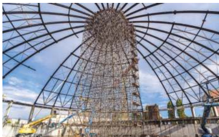
Fot. 5. Rusztowanie dla prac związanych z montażem stalowej kopuły hali widowiskowo - sportowej - Hala Urania w Olsztynie
