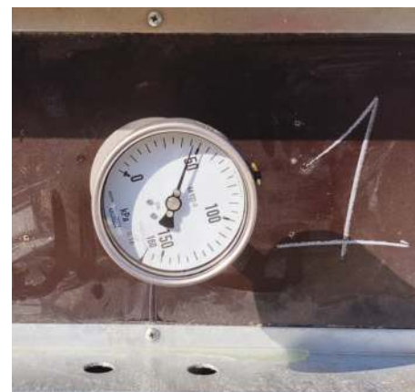
Fot.1. Przyrząd zegarowy pozwalający zmierzyć stan naprężenia wywołany parciem świeżej mieszanki betonowej (w czasie rzeczywistym)
