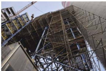
Fot. 4. Rusztowanie modułowe do modernizacji i wymiany kanału spalin między absorberem a kominem na istniejącej instalacji – Grupa Azoty Zakłady Azotowe w Puławach
