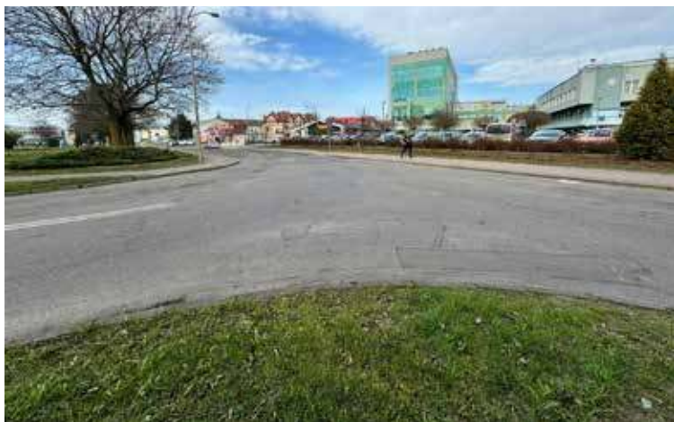
W tym miejscu powstanie małe rondo
