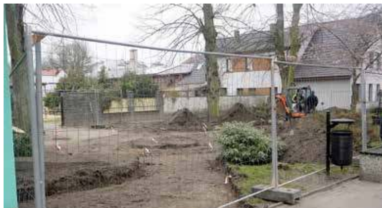
Trwają prace nad przebudową skweru w centrum miasta (fot. Gm. Maszewo)
