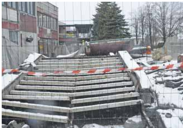
Schody z estakadą są rozbierane. Nie zdecydowano się na ich remont
