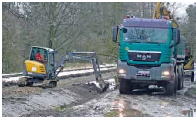
Budowa drogi rowerowej przy torach kolej wąskotorowej, okolicy parku Piny
