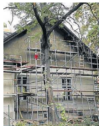
W Modrzejówce trwają jeszcze prace remontowe
