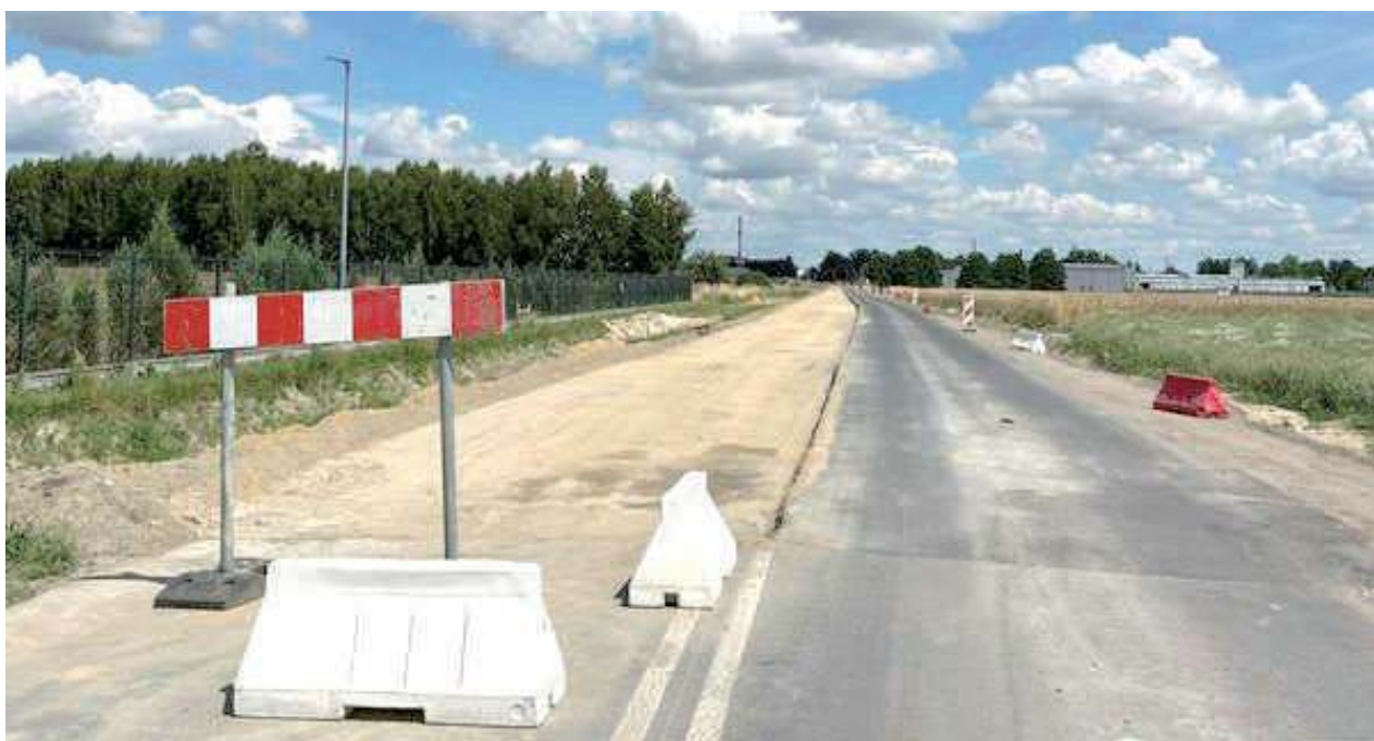
Podbudowa jednej strony ul. Polnej jest gotowa
