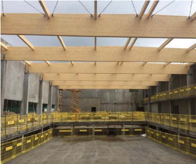
Nad basenami już stoją pierwsze krokwie dachowe
