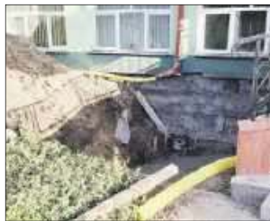
Obecnie na placu budowy trwają prace w przyziemiu. Finał inwestycji zaplanowano na koniec tego roku. Koszt przedsięwzięcia to ponad 410 tys. zł.
