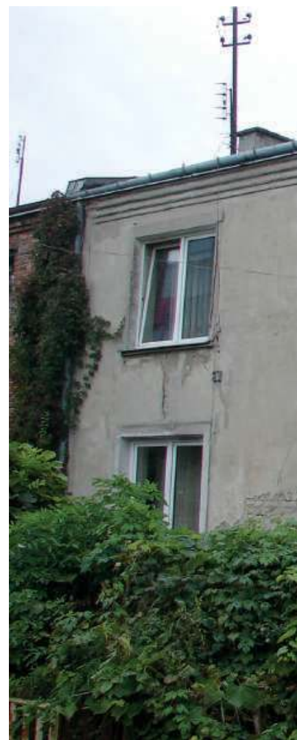
Kamieniczka przy ul. Ruchliwej 25 i data jej wzniesienia
