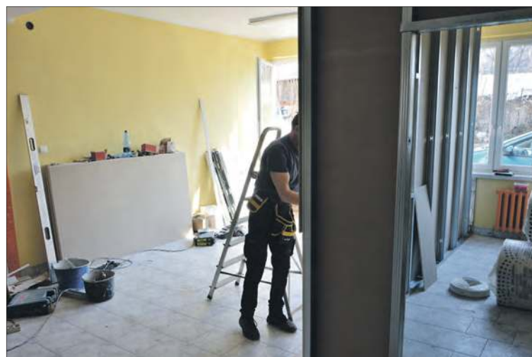
Przyszła przychodnia POZ jeszcze w trakcie remontu
