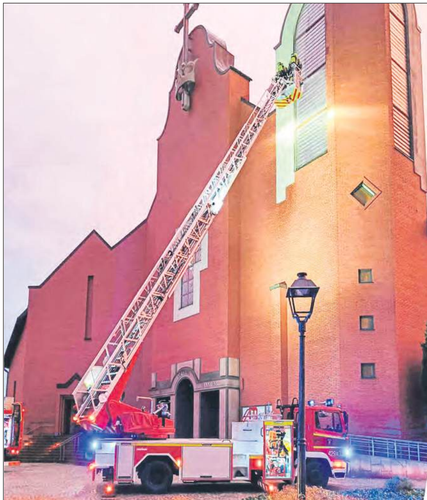
+ Na miejsce zdarzenia zadysponowano aż siedem zastępów straży pożarnej, w tym specjalistyczny wóz z drabiną z OSP Garwolin
