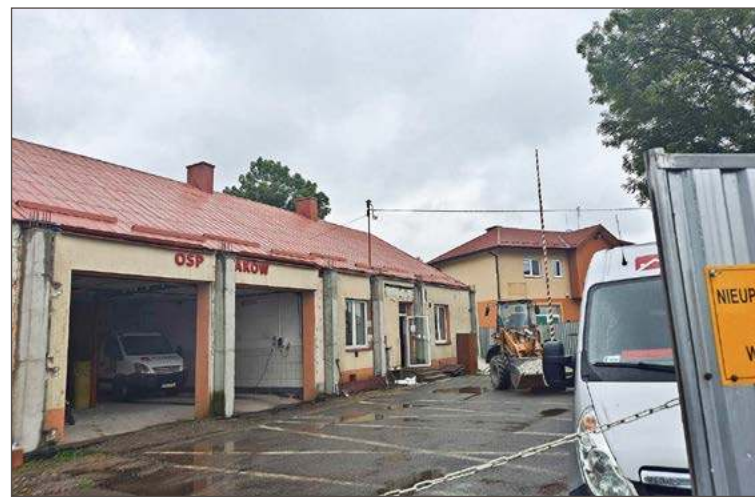
Prace przy remizie w Żyrakowie ruszyły na nowo.
