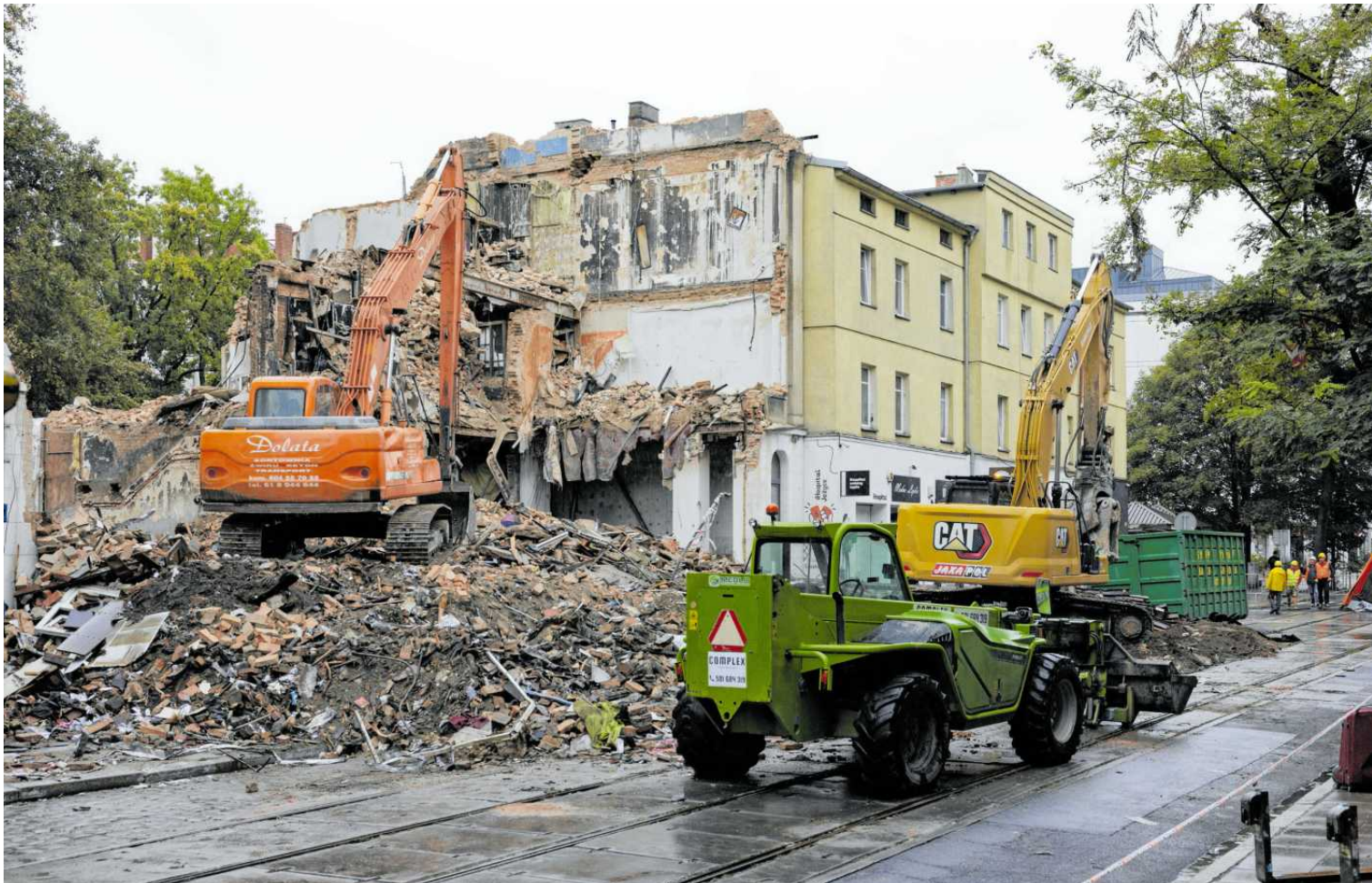
• Rozbiórka spalonej kamienicy przy Kraszewskiego 12 FOT. ŁUKASZ CYNALOWSKI / AGENCJA WYBORCZA.PL
