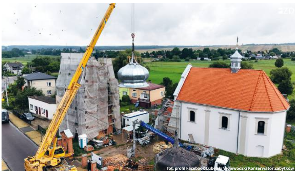
Kopułę dzwonnicy umieszczono już na właściwym miejscu
