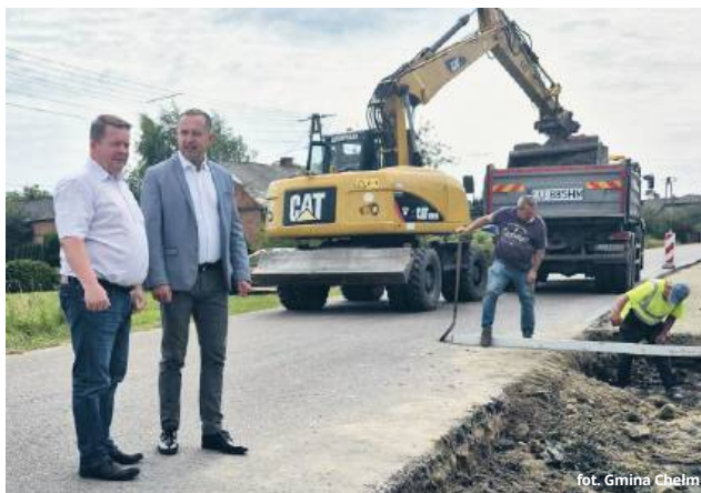
Prace drogowe w Horodyszczu
