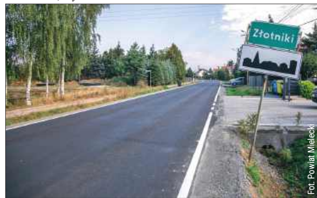
Nowa nawierzchnia w Złotnikach.
