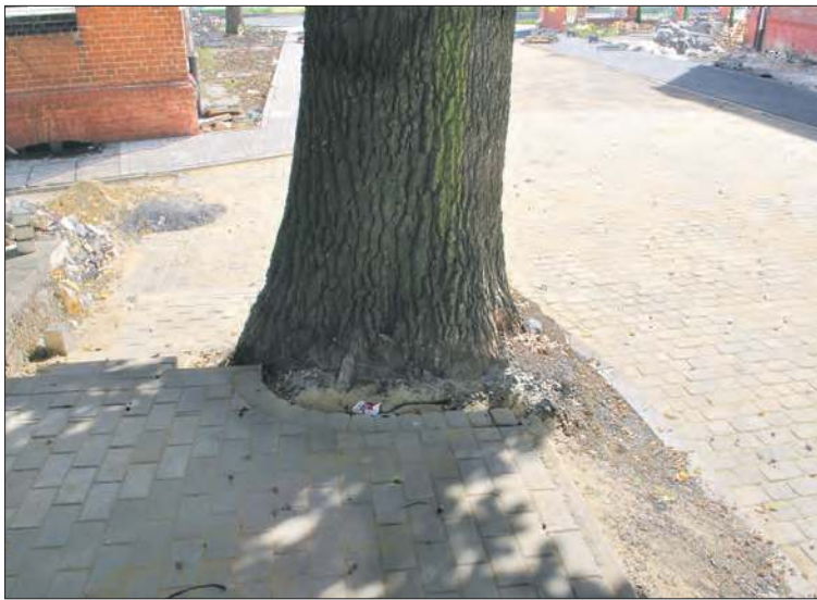
Przygotowanie i wykonana betonoza na ul. Legionów
