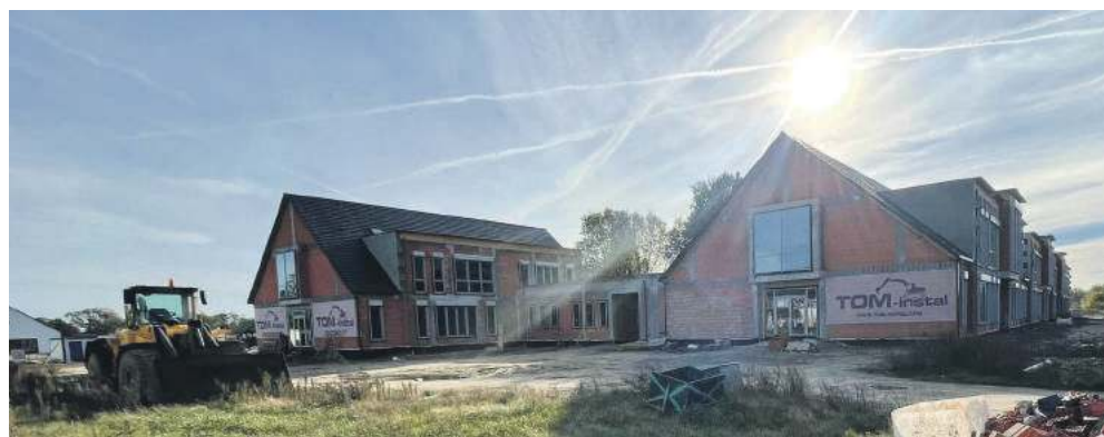
Niedługo szkoła otrzyma nowy budynek
