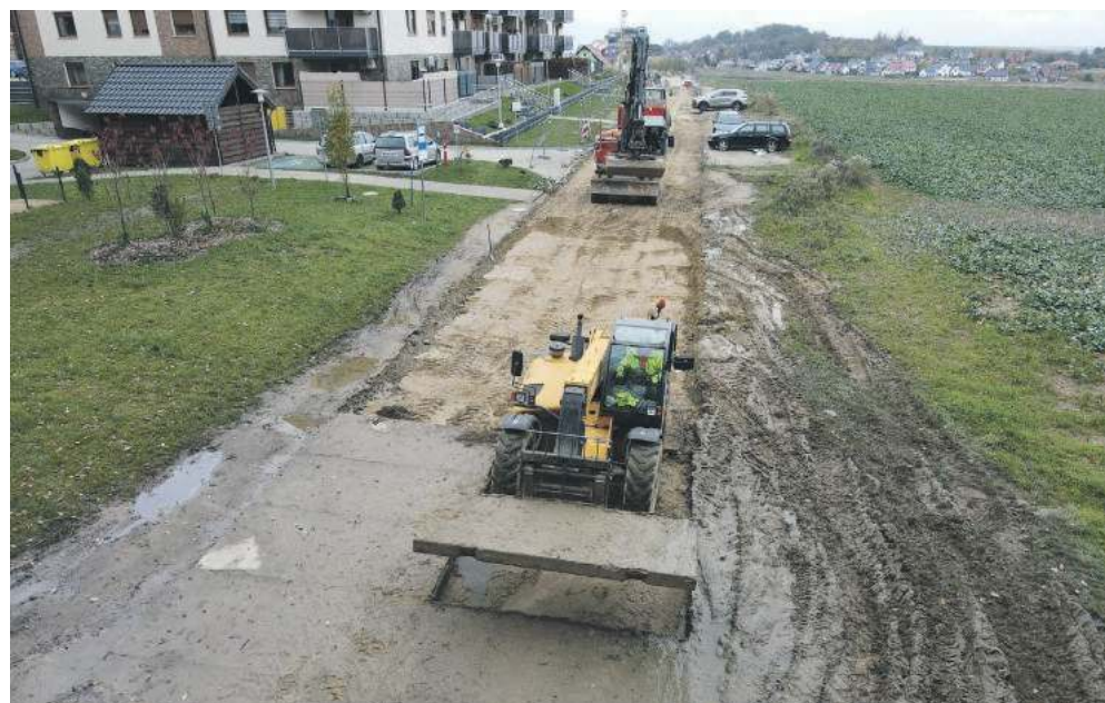
Budowa ruszyła, a płyty składowane są przy lesie
