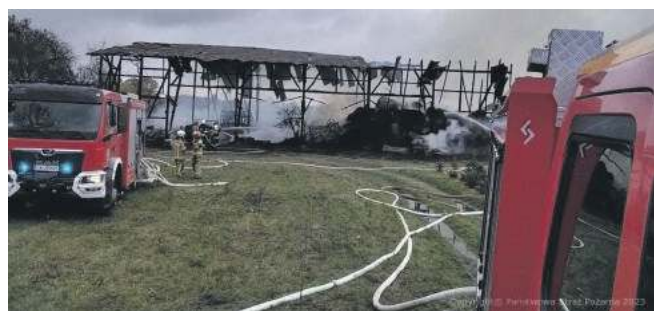
Stodoła została zniszczona
