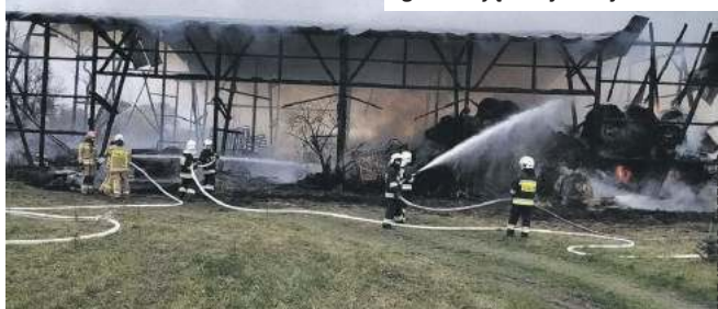
Pożar gasiło 9 zastępów
