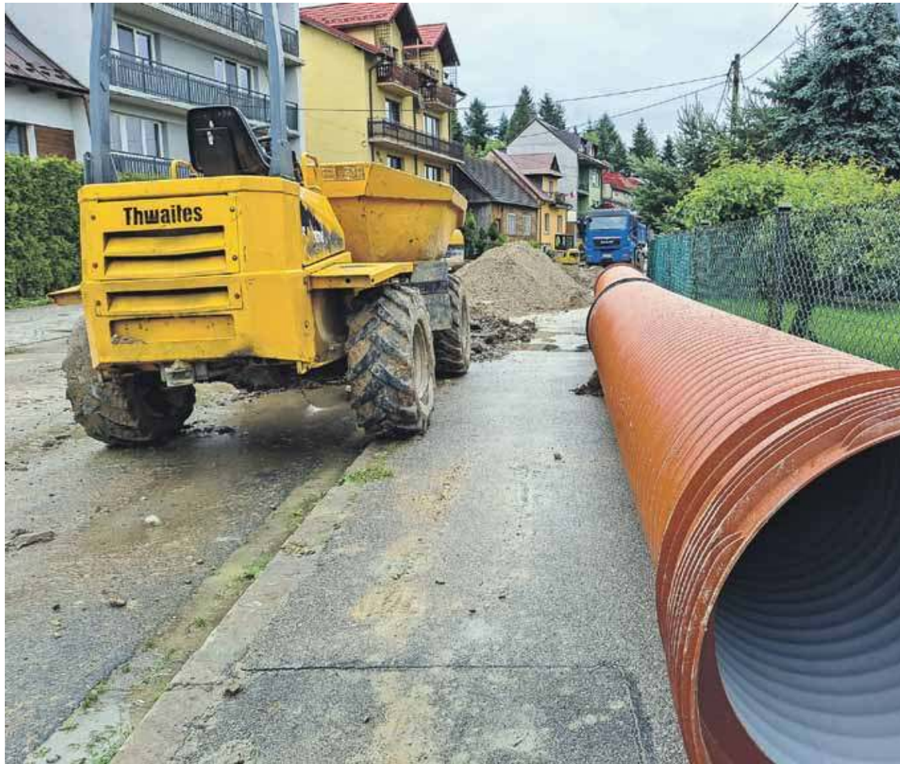
Ul. Grel ma być nieprzejezdna do końca lipca.
