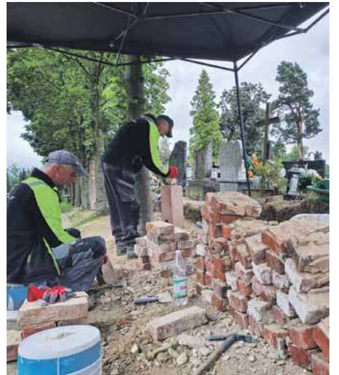
Robotnicy muszą każdą zabytkową cegłę pieczołowicie oczyścić z zaprawy, by potem wykorzystać je przy budowie kolumbarium.
