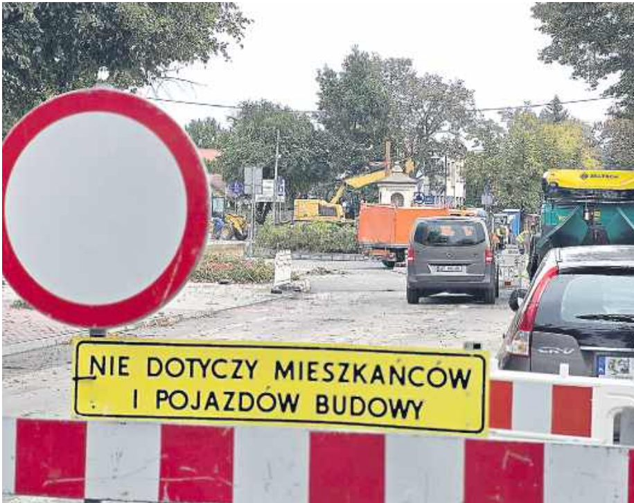
Jak długo potrwa remont?
