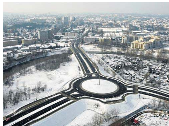
Wisłokostrada to 2 km nowej drogi. Ma pomóc odkorkować północną część Rzeszowa
