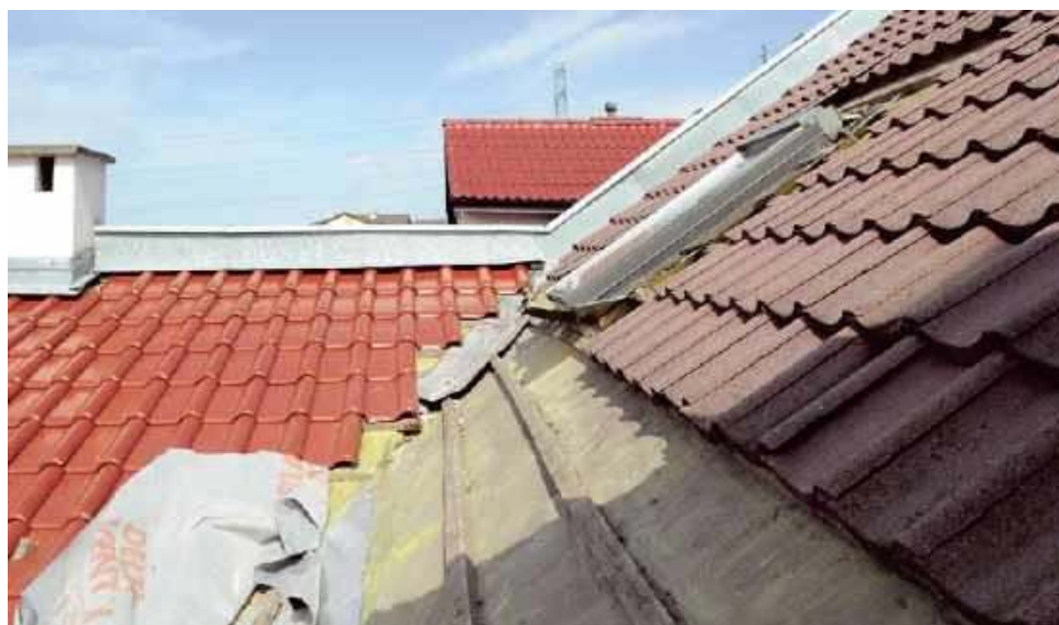
🔧 Wymiana pokrycia to remont, którego nie trzeba zgłaszać w urzędzie, o ile obszar oddziaływania inwestycji w całości mieści się na działce inwestora. RÖBEN
