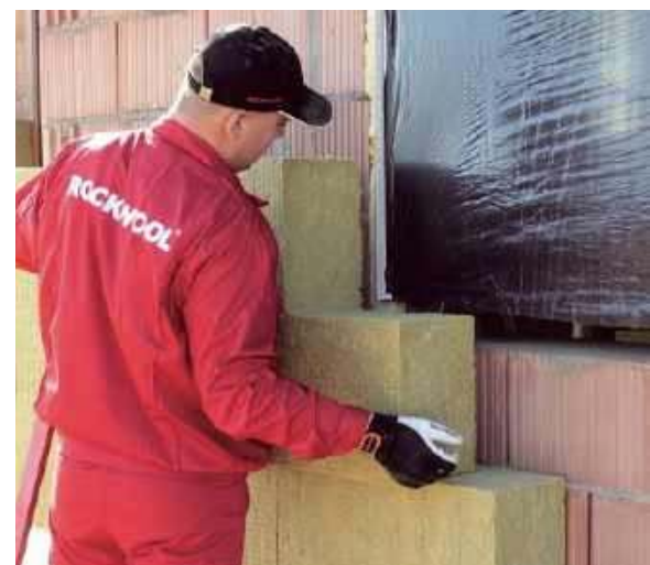
🔑 Wełna mineralna jest materiałem wytwarzanym ze skał, piasku, stłuczki szklanej. Jedną z jej najważniejszych cech to niepalność. ROCKWOOL
