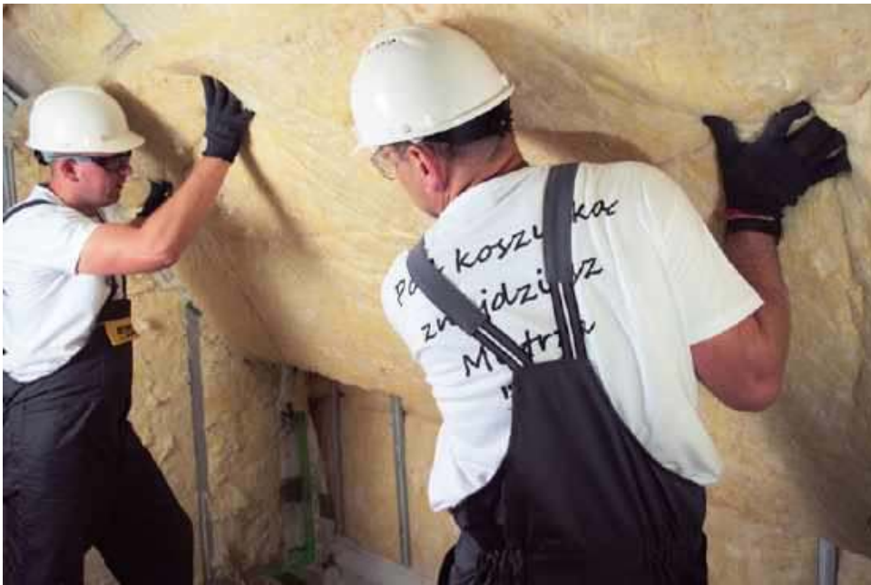
🔧 Izolację cieplną na poddaszu układa się zwykle między i pod krokiewiami. Powszechnie stosuje się produkty z wełny mineralnej, która dobrze wypełnia przestrzeń między belkami. Ostatnio popularność zyskuje ocieplenie z pianki poliuretanowej, aplikowanej natryskowo. ISOVER
