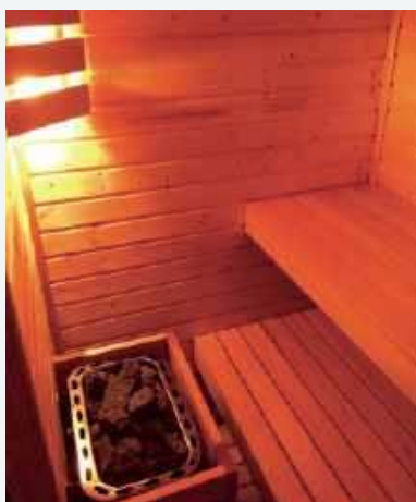
☛ Jednofunkcyjny piec o mocy 6 kW (dopasowany do kubatury kabiny), lampa boczna.
