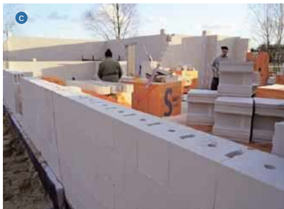
U Najpopularniejsze materiały ściennie: beton komórkowy (a TERMALICA BRUK-BET), ceramika poryzowana (b WIENERBERGER), silikaty (c H+H).
