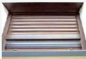
🔗 Rolety i podtynkowa skrzynka z dolną kłapą rewizyjną.
