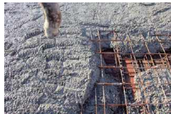
📌 Strop monolityczny to ułożone na pełnym deskowaniu zbrojenie ze stalowych prętów, które zalewa się betonem. J. WERNER
