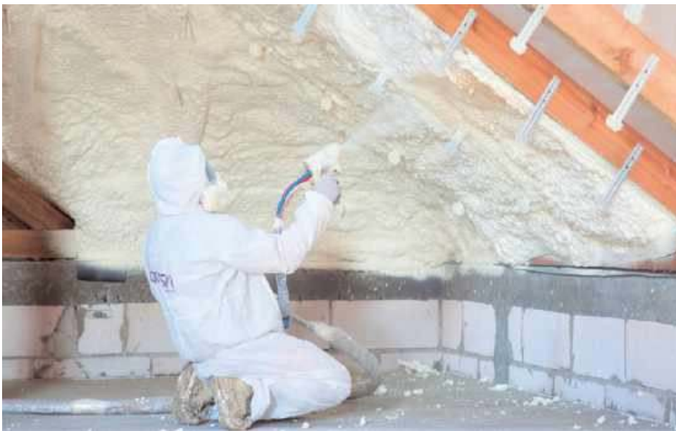
🔧 Jednym z podstawowych atutów pianki jest szybkość wykonania izolacji, a co za tym idzie – niskie koszty robocizny. PCC PRODEX
