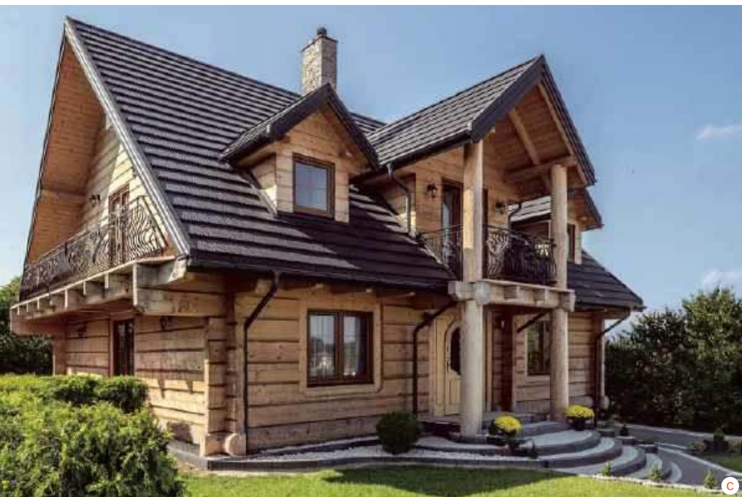
➊ Na remontowanych dachach najłatwiej ułożyć lekkie pokrycie z blachy: klasyczną blachodachówkę (a RUUKKI), blachę, która wygląda jak modne dachówki płaskie (b BUDMAT), albo imitującą drewniany gont (c BLACHY PRUSZYŃSKI).
