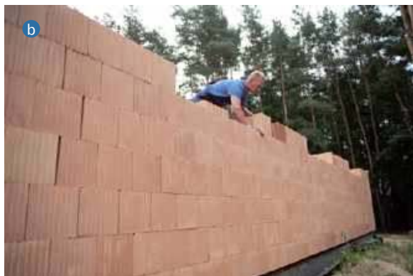
U Najpopularniejsze materiały ściennie: beton komórkowy (a TERMALICA BRUK-BET), ceramika poryzowana (b WIENERBERGER), silikaty (c H+H).
