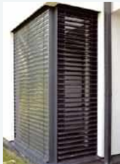
❶ Kasety i prowadnice zakryte tynkiem.
