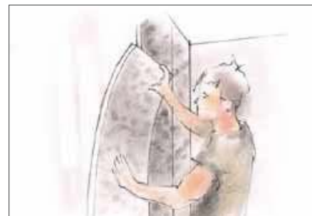
❸ Po odczekaniu 10–30 minut (w zależności od temperatury i wilgotności pomieszczenia) przyłożenie płyty do ściany i dociskanie przez ok. 30 sekund.
