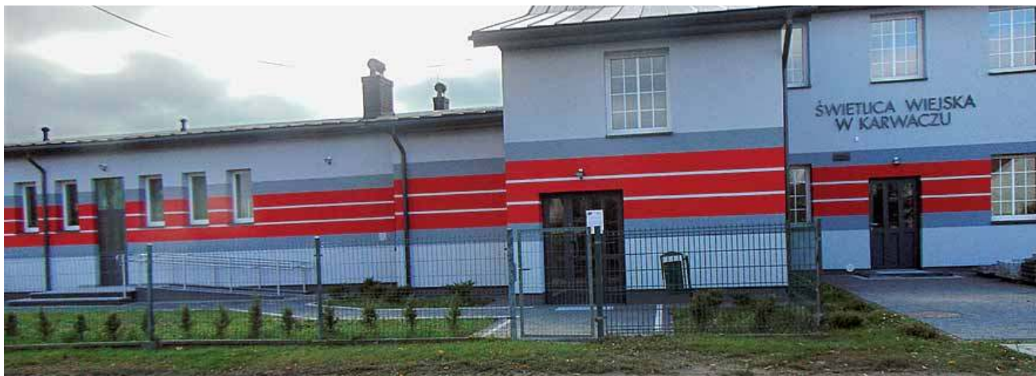
Przebudowa świetlicy gminnej w Karwaczu
