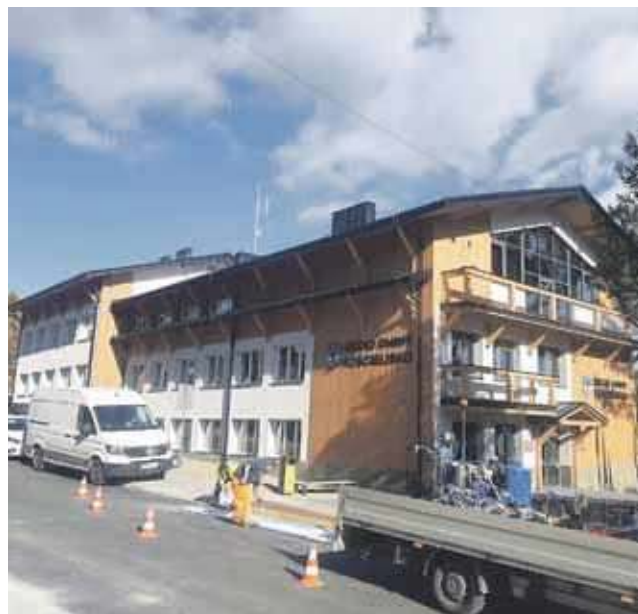
Nowa droga, nowy urząd, to i pasy na przejściu dla pieszych muszą być nowe. Trwają ostatnie prace po urzędowej przeprowadzce w Kościelisku.
