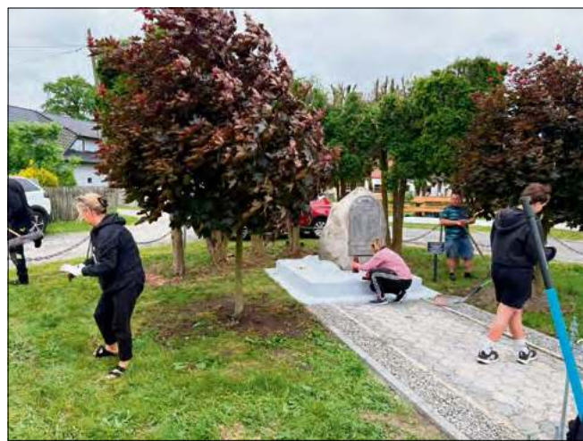
W ramach prac przy pomniku wykonano m.in. przycinkę tui, wygrabienie trawnika, czyszczenie chemiczne kamienia, podestu i kostki, piaskowanie oraz impregnację.
