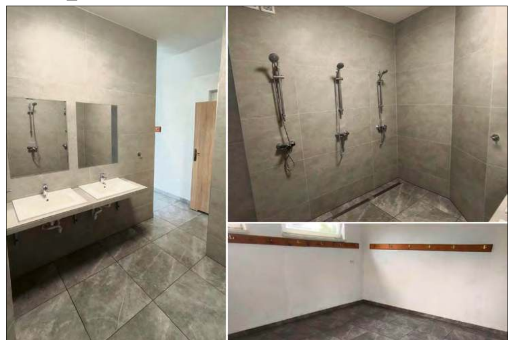
Odnowione wnętrze szatni na stadionie w Szczedrzyku.
