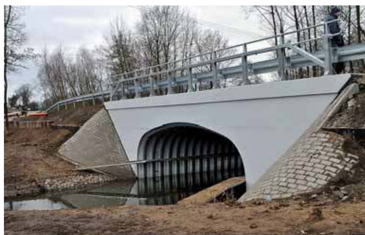
Do 10. miejsca Powiatu Pułtuskiego przyczyniły się szczególnie inwestycje drogowe, w tym budowa mostu przez rzekę Niestępowkę w m. Koziegłowy
