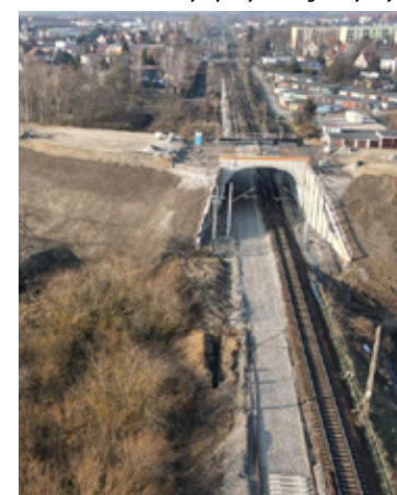
Wiadukt w trakcie budowy wraz z drogami.
