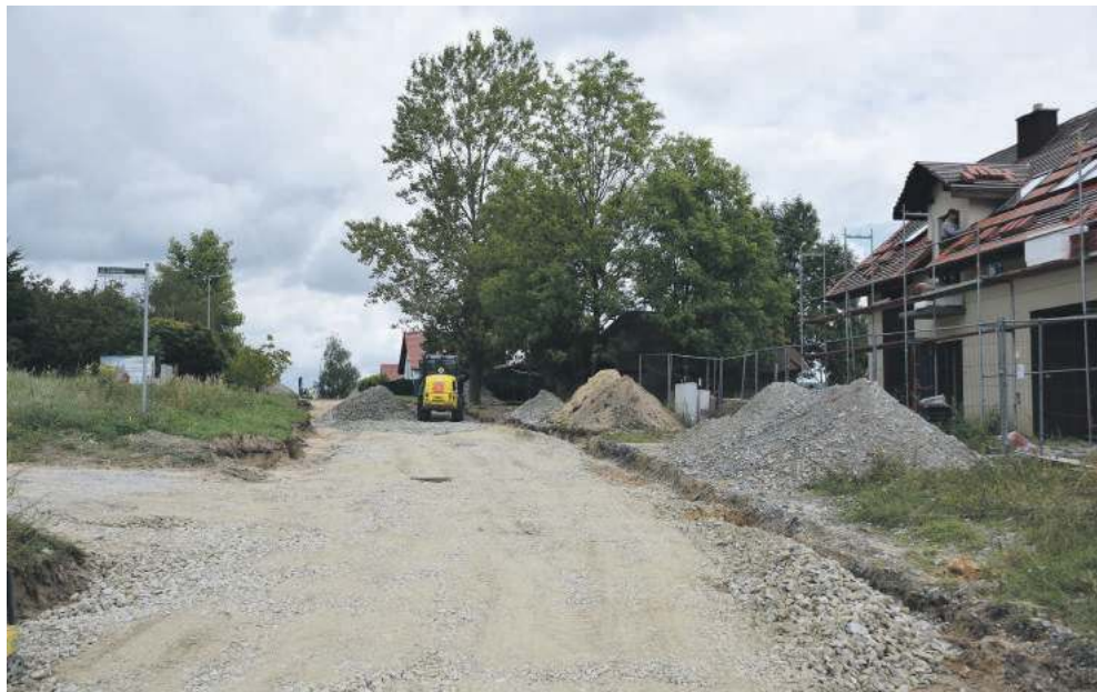
W Wiszni Małej rozpoczął się II etap budowy ul. Polnej
