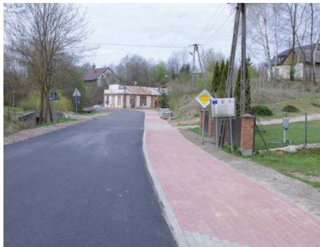
Jak wygląda ulica Starowiejska po przebudowie, pochwalił się na swoim profilu na Facebooku wójt gminy Karczmiska
