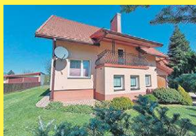
Dom przy ulicy Wyzwolenia, pow. 157,60 m 2 , 604 494 489
