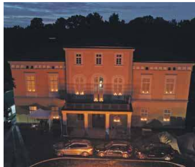
Do sieci kanalizacyjnej zostanie podłączony także wyremontowany w ostatnich latach pałac w Zielonej
