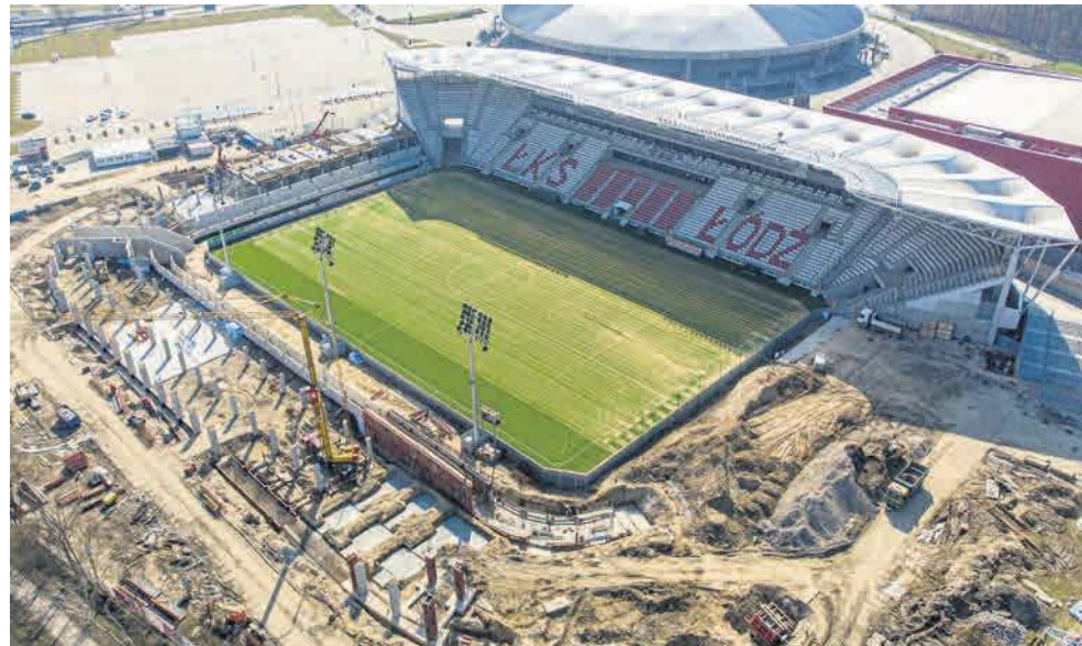
Mimo epidemii prace na budowie stadionu przy al. Unii przebiegają zgodnie z planem
