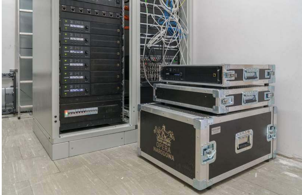
Wszystkie wymienione urządzenia głośnikowe zasilane są ze wzmacniaczy L-Acoustics LA4X, z których większość zainstalowana jest w szafie teletechnicznej znajdującej się w amplifikatorni.
