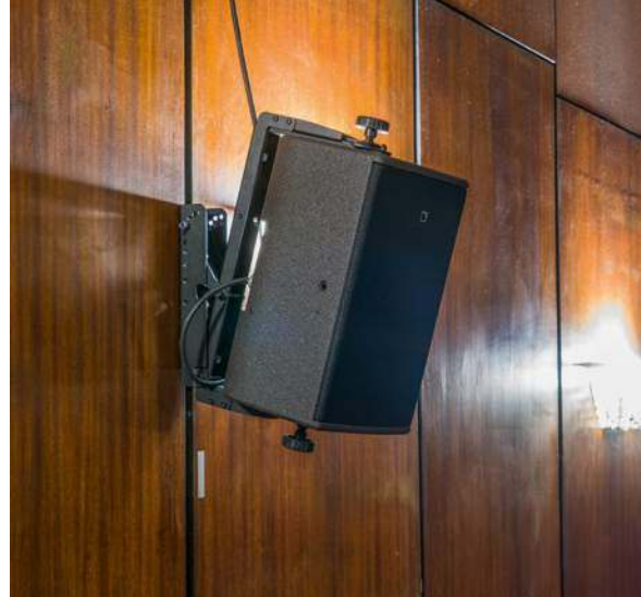
Zestawy efektowe to zamontowane na tylnej ścianie widowni (z możliwością demontażu) szerokopasmowe X8-ki L-Acousticsa.
