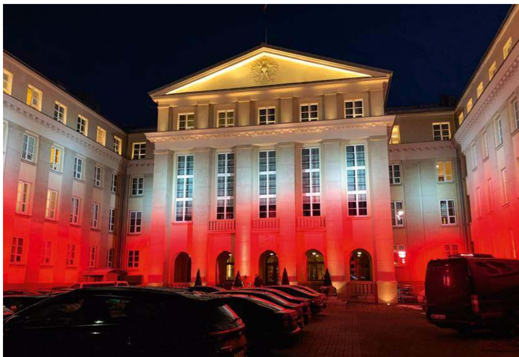
Najnowsza instalacja oświetleniowa gmachu Najwyższej Izby Kontroli została oparta o sterownik CueCore2.
