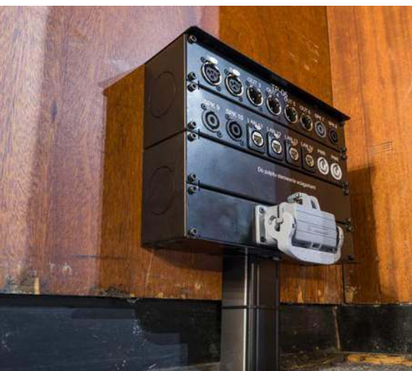
Firma Audio Plus wykonała w obrębie sceny i widowni w sumie 32 przyłącza sygnałowe.
