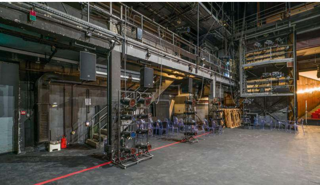
Nagłośnienie sceny zrealizowane jest za pomocą 10 zestawów głośnikowych ARCS WIDE, zawieszonych przy barierach balkonów technicznych po prawej i lewej stronie sceny.
