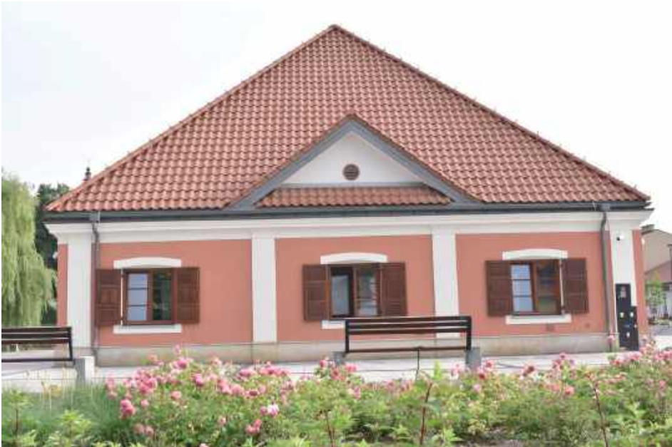
Idea odzyskania przez Końskowolę praw miejskich powróciła na nowo w 2020 r., kiedy oddano do użytku zmodernizowany ratusz
