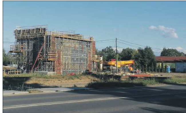
Powstaje już konstrukcja wiaduktu kolejowego, który powstaje na granicy Chorzeliwa z Mielcem.
