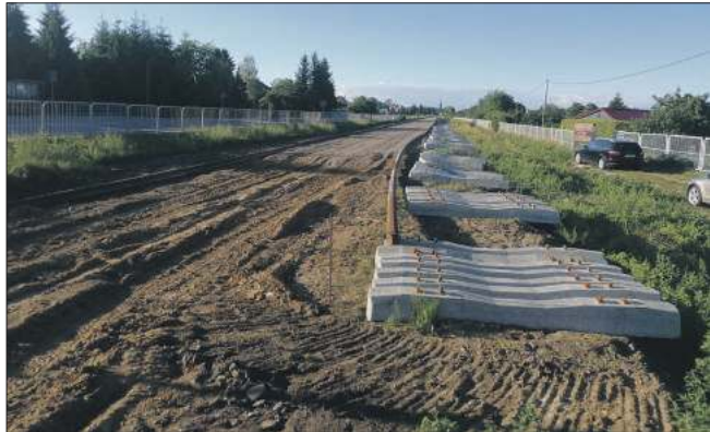
Na całym odcinku linii kolejowej od Mielca do Padwy trwają prace modernizacyjne. Utwardzany jest grunt. Budowane są przepusty, a także perony.
