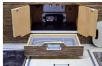
Szuflada na sztućce, nad nią szafka, w której ukryto centralkę sterowania zasilaniem z paneli fotowoltaicznych. System jest automatyczny i bezobsługowy
