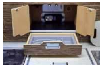
Szuflada na sztućce, nad nią szafka, w której ukryto centralkę sterowania zasilaniem z paneli fotowoltaicznych. System jest automatyczny i bezobsługowy
