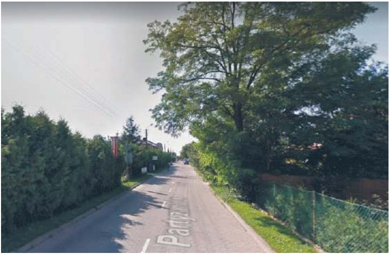
Wiele ogrodzeń posesji wzdłuż ulicy Partyzantów stoi w pasie drogowym i wybudowanie chodnika nie obędzie się bez ich rozbiórki
