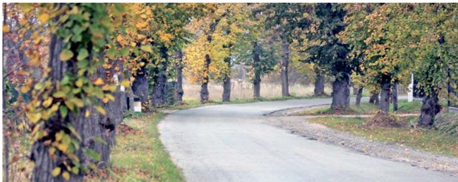
Droga jest w bardzo złym stanie technicznym. Jej przebudowa wymusiłaby wycinkę przydrożnych drzew
