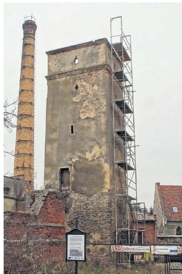
Jeszcze w grudniu wykonano pierwszy etap remontu zabytkowej baszty, który powstrzyma jej degradację
