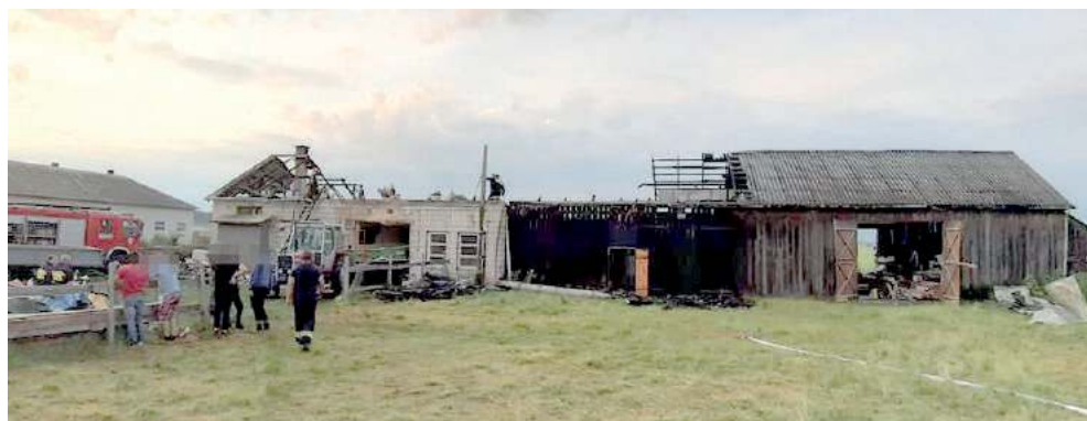
O godz. 17 w Nowinach wybuchł pożar. Prawdopodobnie od pioruna zajęta się stolarnia połączona z budynkiem gospodarczym. Starty oszacowano na 200 tys. zł
