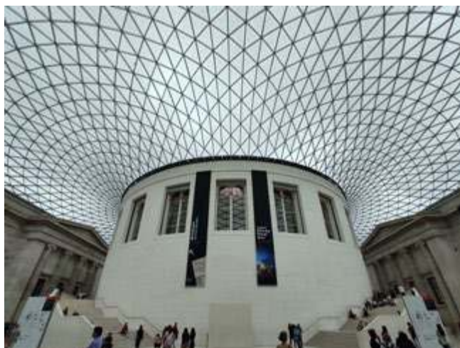
Dziedziniec British Museum nakryty szklano-stalowym dachem wykonanym według projektu sir Normana Foster'a
