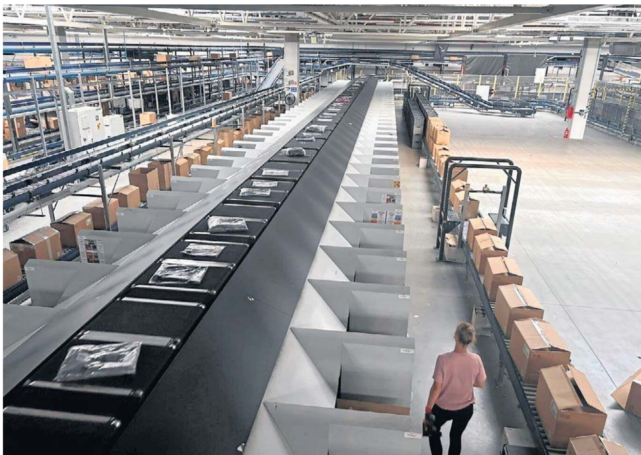
Telemetria, wymiana oświetlenia na LED-y, wyłączanie komputerów pozwoliły zredukować zapotrzebowanie na energię o 20 procent w salonach i magazynach
